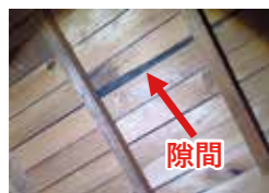
小幅板の隙間が分かる写真
