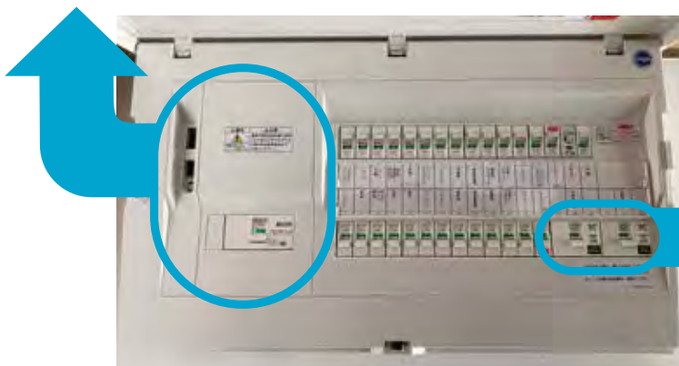
panasonic製スマート分電盤の例
