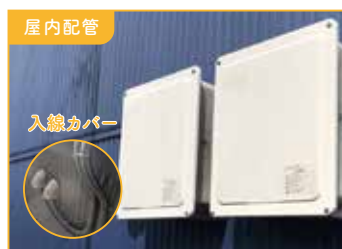
屋内配管 入線カバー パワーコンディショナへの配管・配線が壁内を通ります。
