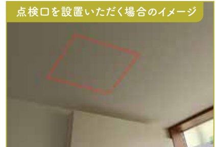
点検口を設置いただく場合のイメージ 屋内の配線をする場合に、点検口をビルダー様にて複数箇所設置いただく必要が発生する場合があります。
