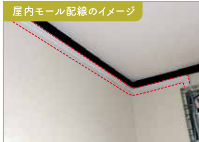
屋内モール配線のイメージ 屋内側の配線が内壁材の外側を通る場合があります。(赤線部)
