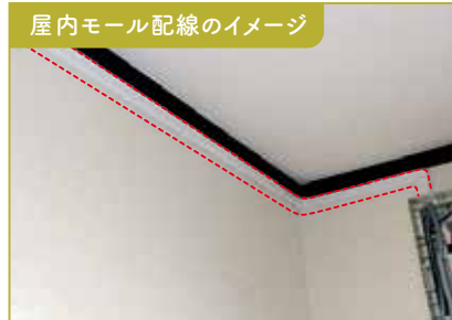
屋内モール配線のイメージ 屋内側の配線が内壁材の外側を通る場合があります。(赤点線部)
